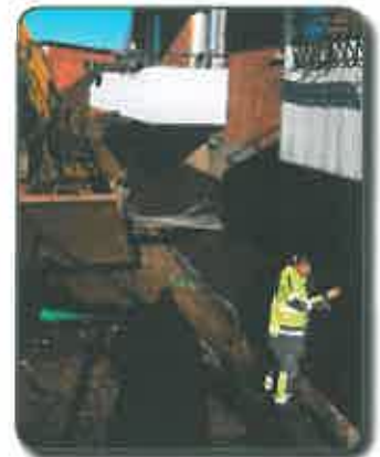
Fukt- och värmeisolering på Infanterigatan 7
