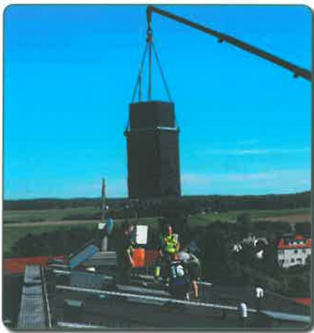
Nya fläktar med värmeväxlare monteras på Tingsgatan 29
