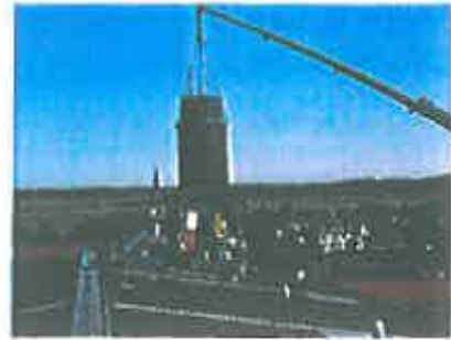
Nya fläktar med värmeväxlare monteras på Tingsgatan 29
