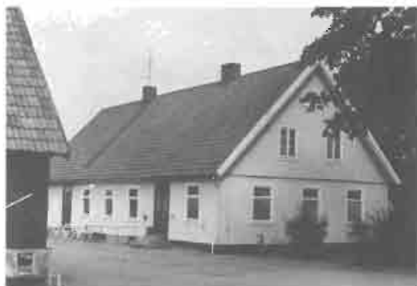
Mangårdsbyggnaden på "Nyhem", sedd från sydost. Ekonomilängan, som skymtar i v., är numera rivet.
