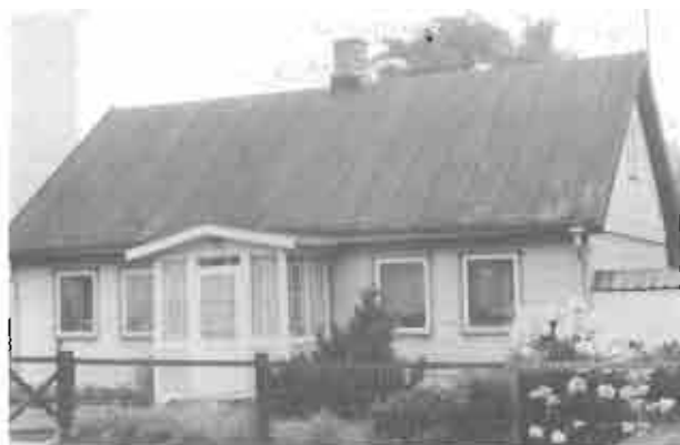
Den här byggnaden, Bruksgatan 13, kvarteret Lyran, uppfördes på 1890-talet i trä och lersten. Fasaderna är idag klädda med gråa sidplattor.
