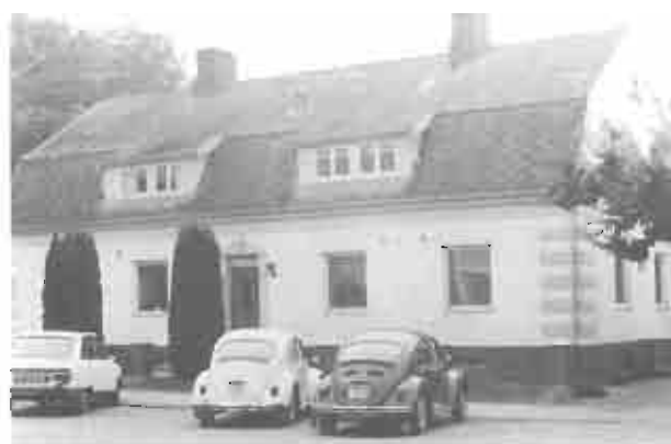
En annan, helt annorlunda byggnad i kvarteret Lyran (Apoteksgatan 5). Huset byggdes 1928 i tegel och fick vitputsade fasader.
