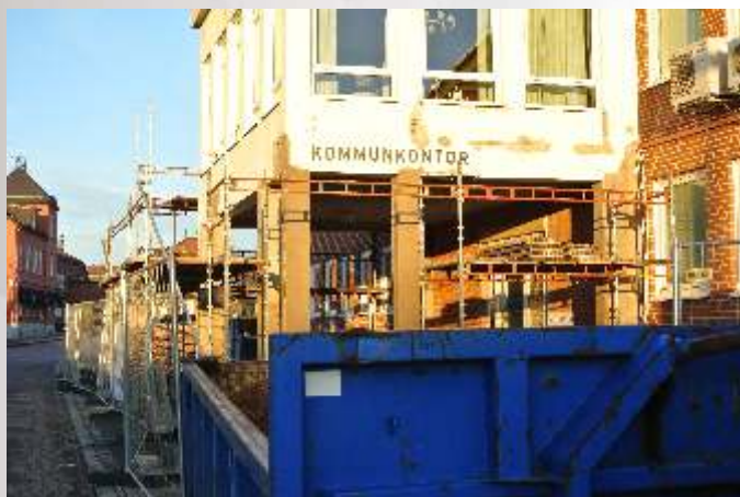
Ombyggnad av kommunhusets entré inför den nya Kundtjänsten
